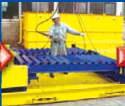
Монтаж промежуточных поддерживающих платформ
