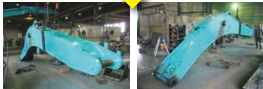
修理後(塗装工程中)
