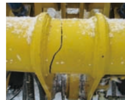
マルチカプラーパイプ亀裂
