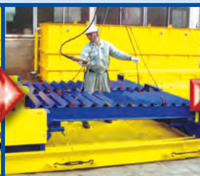
中間架台取り付け
