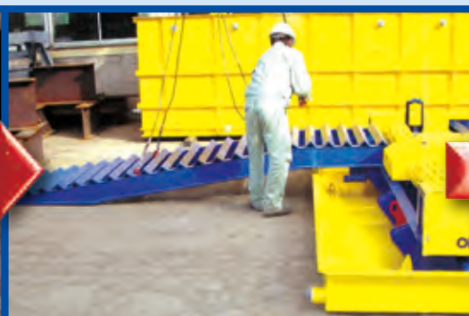
昇降架台取り付け
